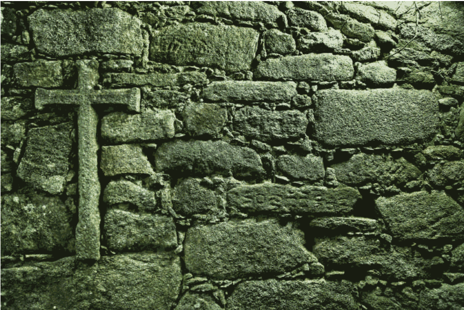
Fig. 205. Muro del atrio de la iglesia de San Martiño de Oleiros con la estela romana en el centro de la imagen.
